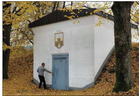
Der Trinkwasser-Hochbehälter Dippling. Das Wasser, das hier ankommt, soll eine Turbine antreiben. – Foto: Roland Binder
